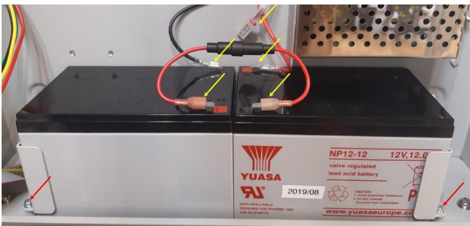
**Figura8: : Local de ligação da bateria para 12 Ah**
